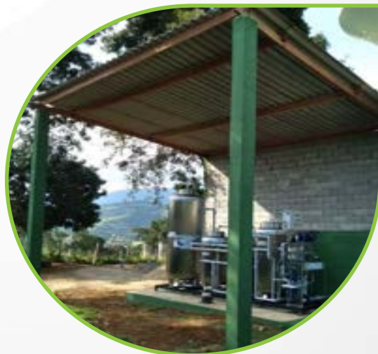
Estação Compacta Instalada
