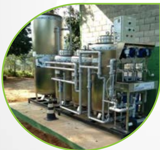
Estação Compacta Instalada
